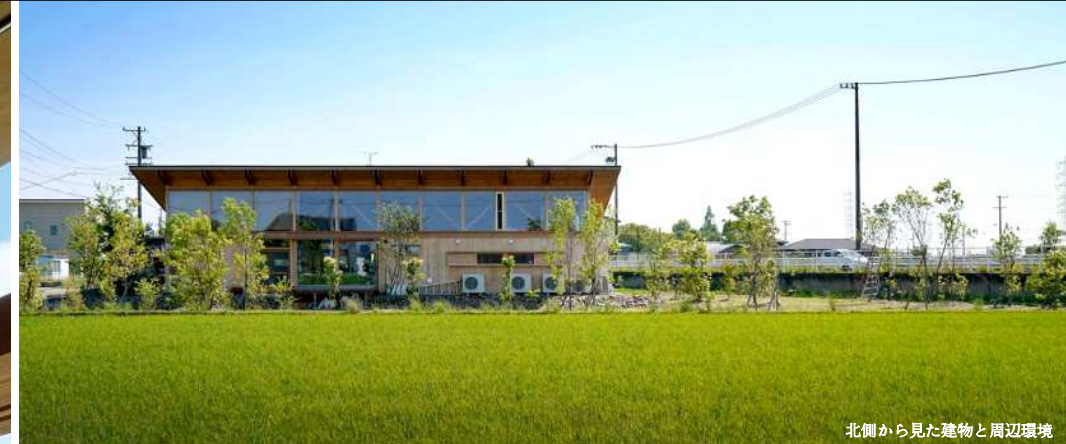
北側から見た建物と周辺環境
