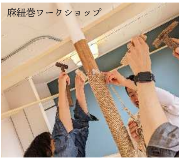
キャットウォーク、可動ステップ、そしてキャットタワー 猫のため。張りめぐらせたキャットウォーク（延長16M）、棚柱を用いたステップ（加齢により高さ変更可）、天井高あるキャットタワーは施主、工務店、設計者で麻紐を巻いて製作。
