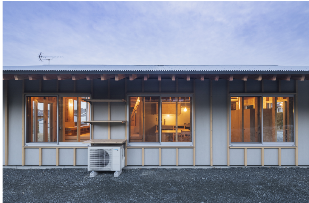
北東側夕景。押縁には設備や棚板が取り付け。
