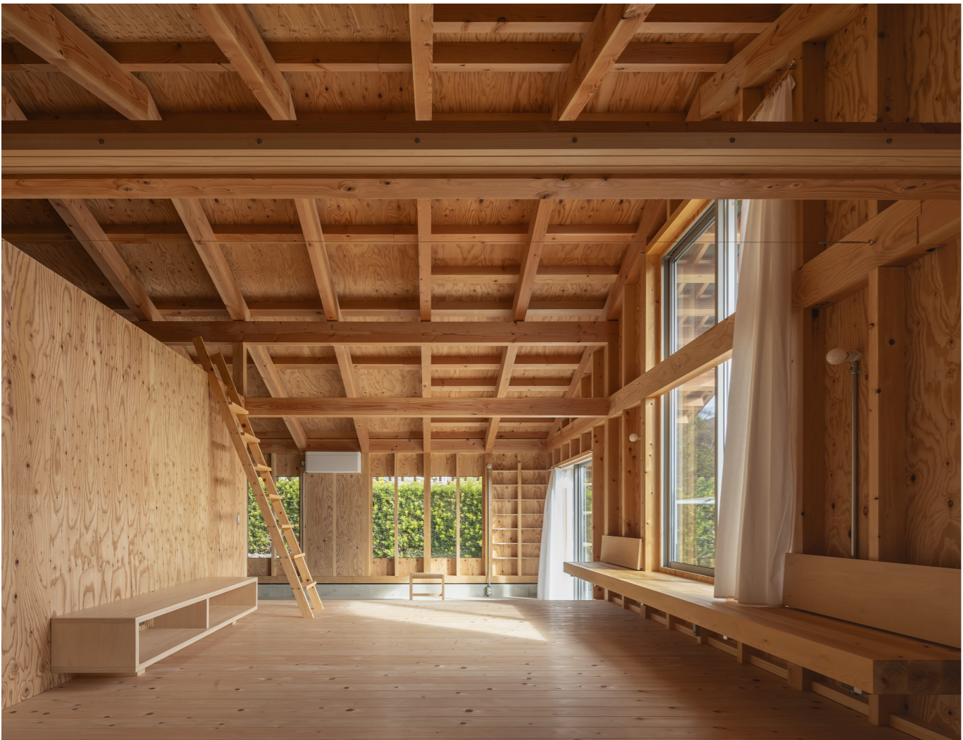
個室1より居間1を見る。天井のペイマツ登り梁は柱、間柱の455mmピッチの2倍の910mmピッチで配置。外部の垂木はその1/4の227.5mmピッチで配置。登り梁に直行する母屋はケラバの跳ね出しのため455mmピッチとその他の910mmピッチで配置している。
