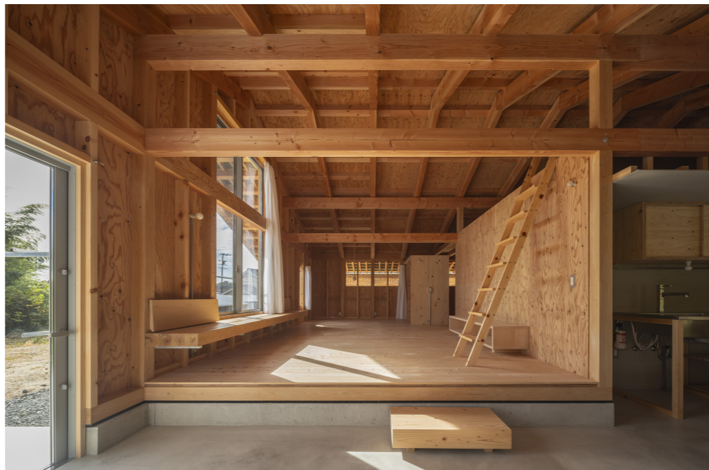
居間1より個室1を見る。居間同士の間には仕切りを設けず、架構や床の高さや異なる床の仕上げによって緩やかに変化を与える。空間の分節と連続の感じ方を体験者に委ねることができる状態を目指している。
