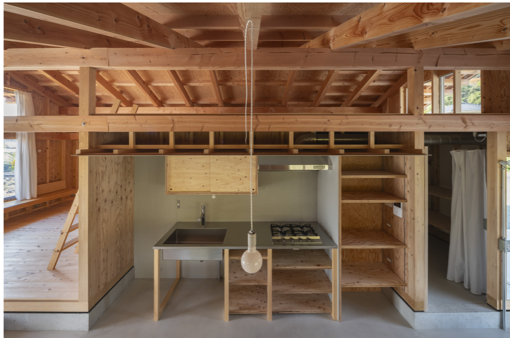
台所。右は166mm上がって水回りと個室3に繋がる納戸。左は330mm上がって居間2。台所天井裏の下地は現しとして、レンジフード用スパイラルダクト奥の洗面脱衣室と繋がっている。
