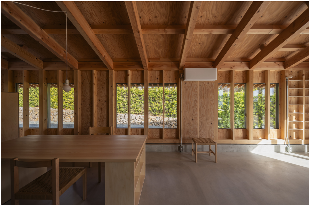
居間1。基礎、パッキン、土台、柱、間柱、耐力壁用構造用合板、桁、登り梁、野地板を現し（作り方の明示）とすることで、作り足すこと、補修すること、作り替えることが容易で道具のように自由な状態を目指した。
