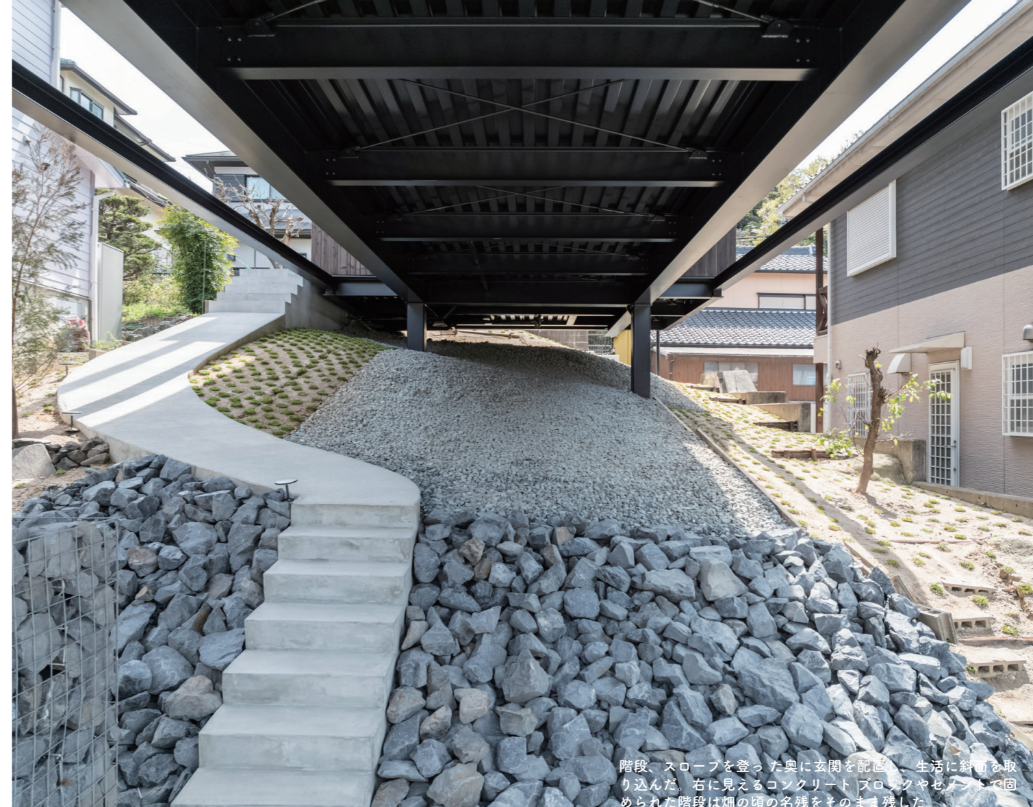
階段、スロープを登った奥に玄関を配置し、生活に斜面を取り込んだ。右に見えるコンクリートブロックやセメントで固められた階段は畑の頃の名残をそのまま残した。
