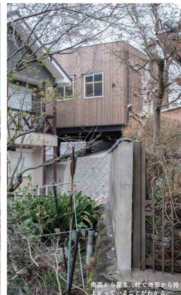
エントランスから前面道路側を見下ろす。階段を数段降り、斜面を降りていくアプローチ。
